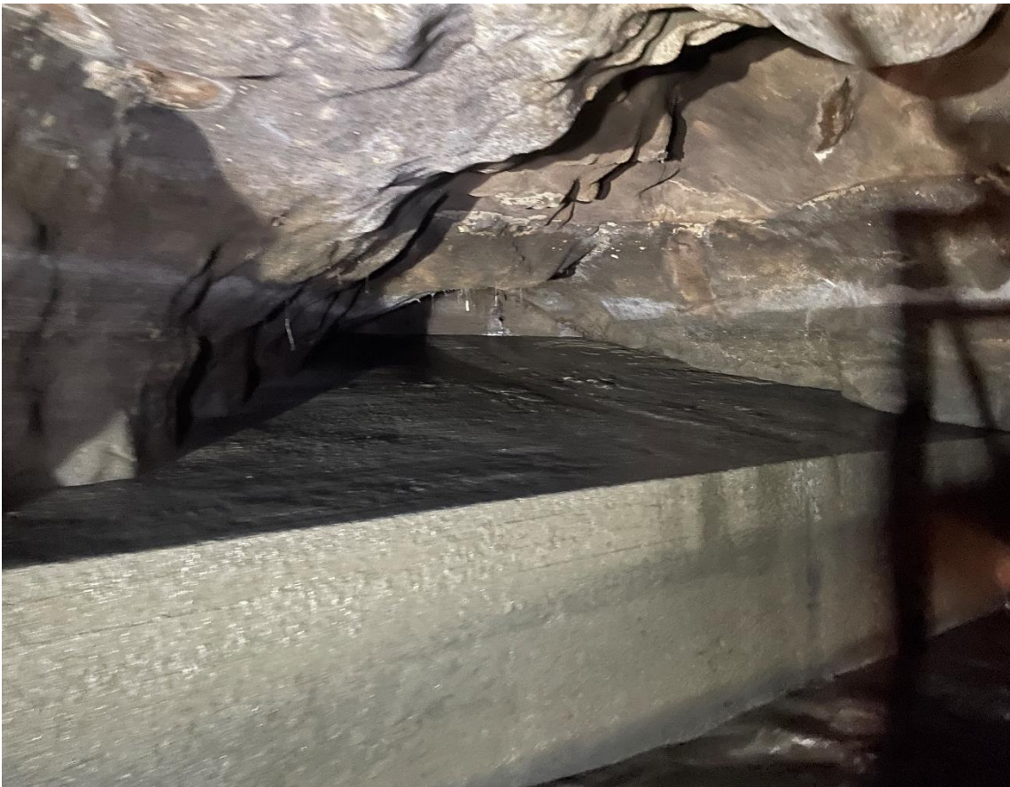
Figur 11 Exempelbild på plugg i arbetstunneln
